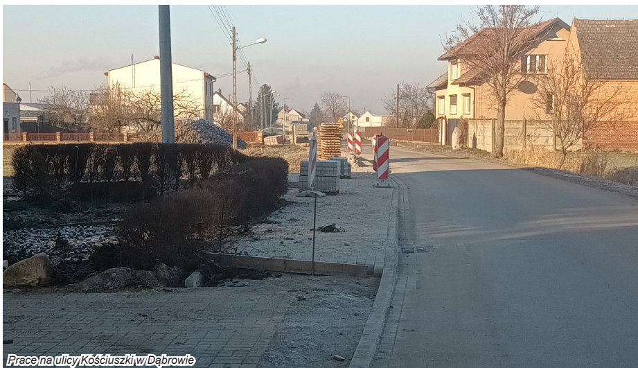
Prace na ulicy Kościuszki w Dąbrowie
