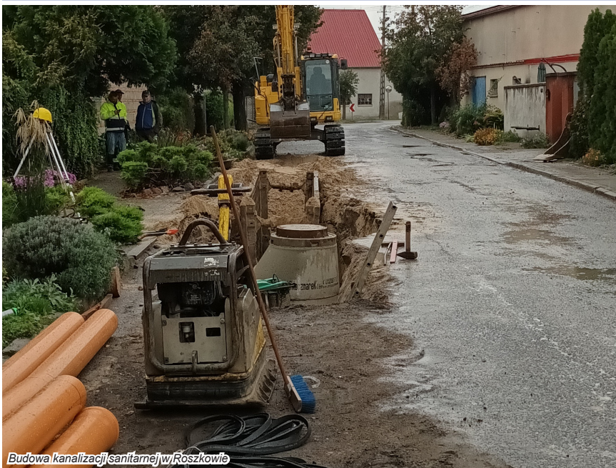
Budowa kanalizacji sanitarnej w Roszkowie
