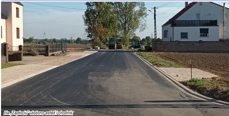
Na „Zapłociu” ułożono asfalt i chodnik
