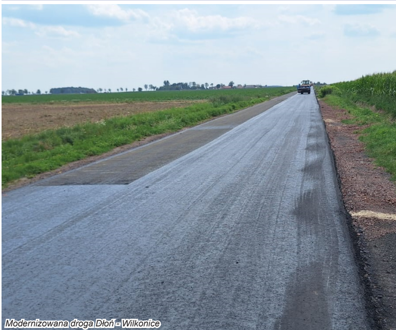
Modernizowana droga Dłoń – Wilkonice
