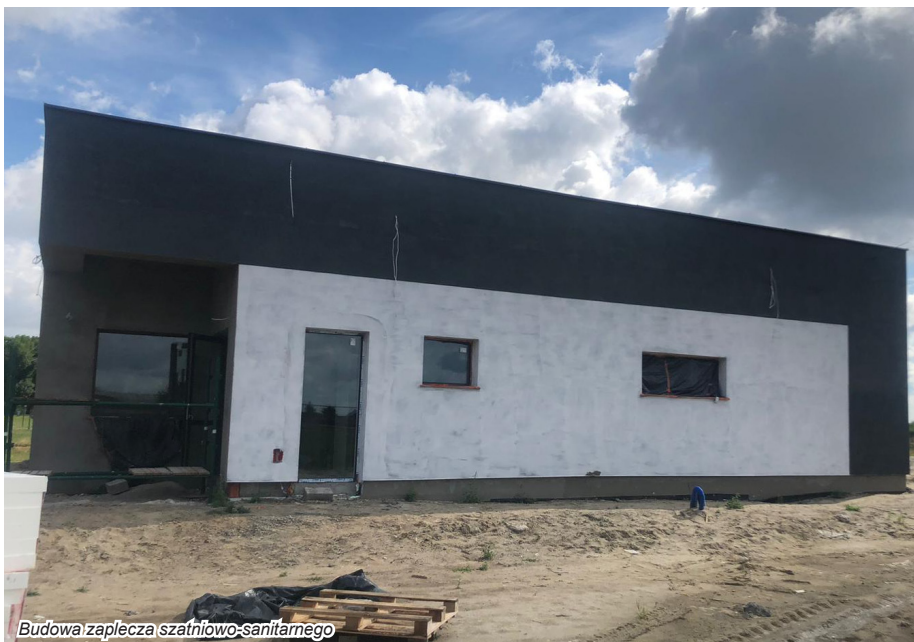
Budowa zaplecza szatniowo-sanitarnego
