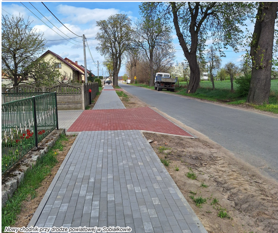
Nowy chodnik przy drodze powiatowej w Sobiałkowie
