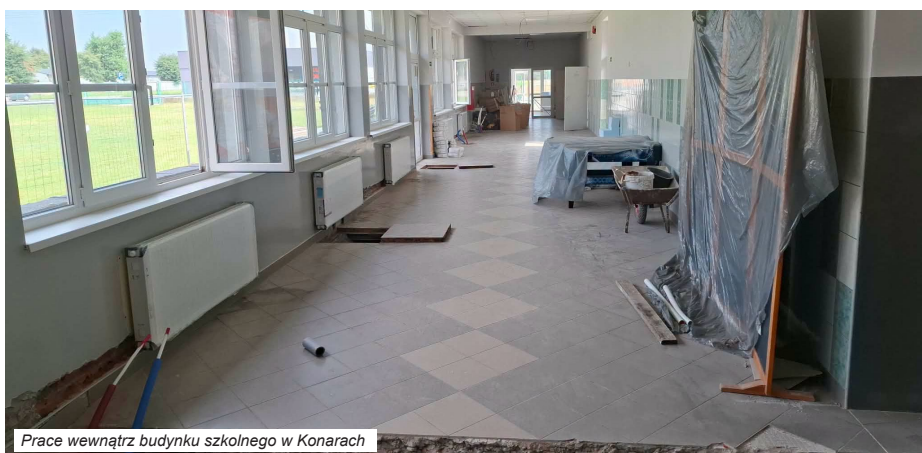
Prace wewnątrz budynku szkolnego w Konarach
